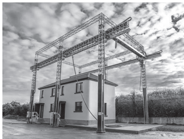
3D建設プリンターによる住宅建設
