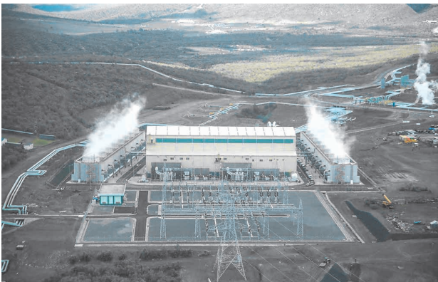
ケニア：オルカリア140MW地熱発電所（写真提供：KenGen）
